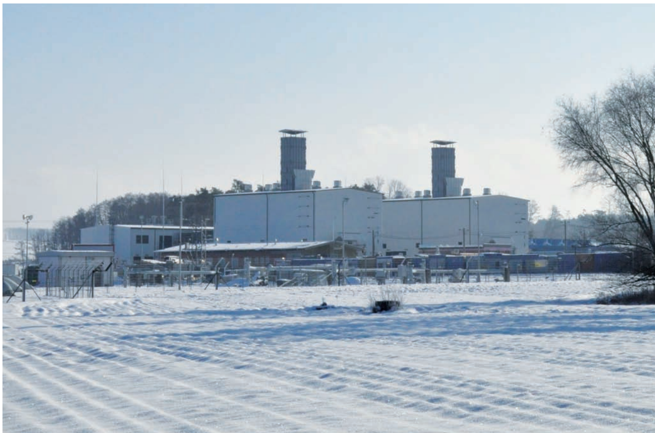
Nová kompresorová stanica pri obci Lakšárska Nová Ves
