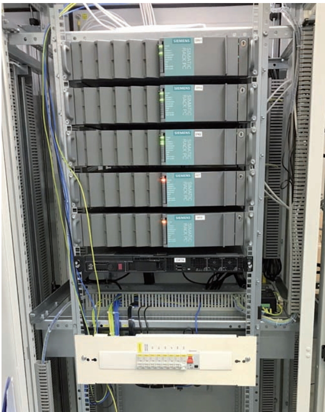
Riadenie kompresorovej stanice zabezpečujú moderné automatizačné systémy.
